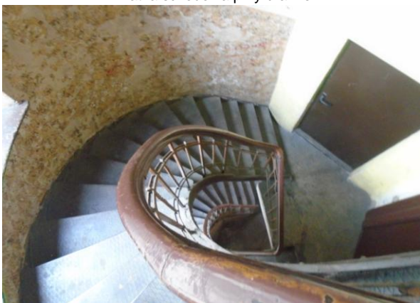
Klatka schodowa od strony podwórza
