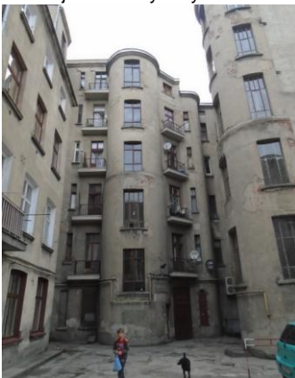
Elewacja budynku frontowego od strony podwórza
