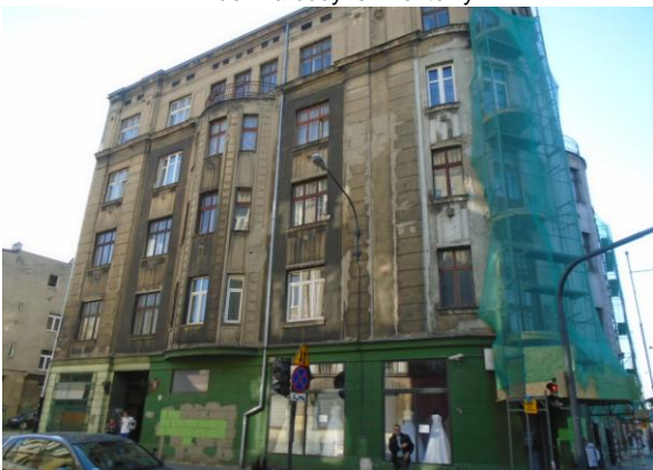
Elewacja od strony ulicy Wschodniej
