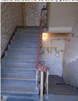
Klatka schodowa budynku oficyny
