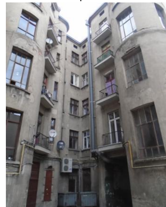
Elewacja budynku frontowego od strony podwórza
