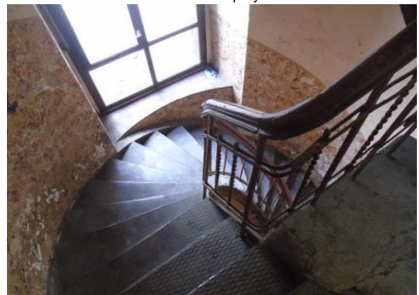
Klatka schodowa od strony podwórza
