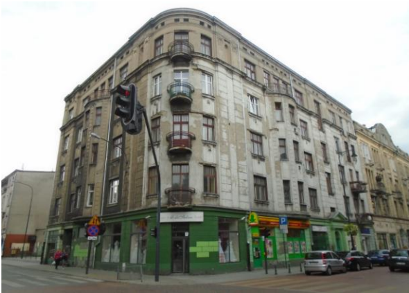
Widok na budynek frontowy
