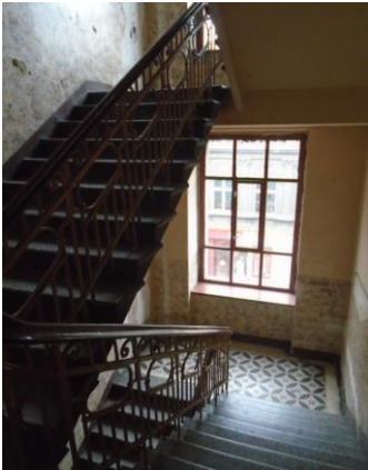
Klatka schodowa od strony ul. Jaracza
