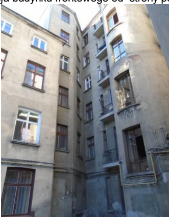
Elewacja budynku frontowego od strony podwórza
