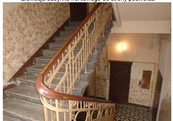
Klatka schodowa od strony ul. Jaracza
